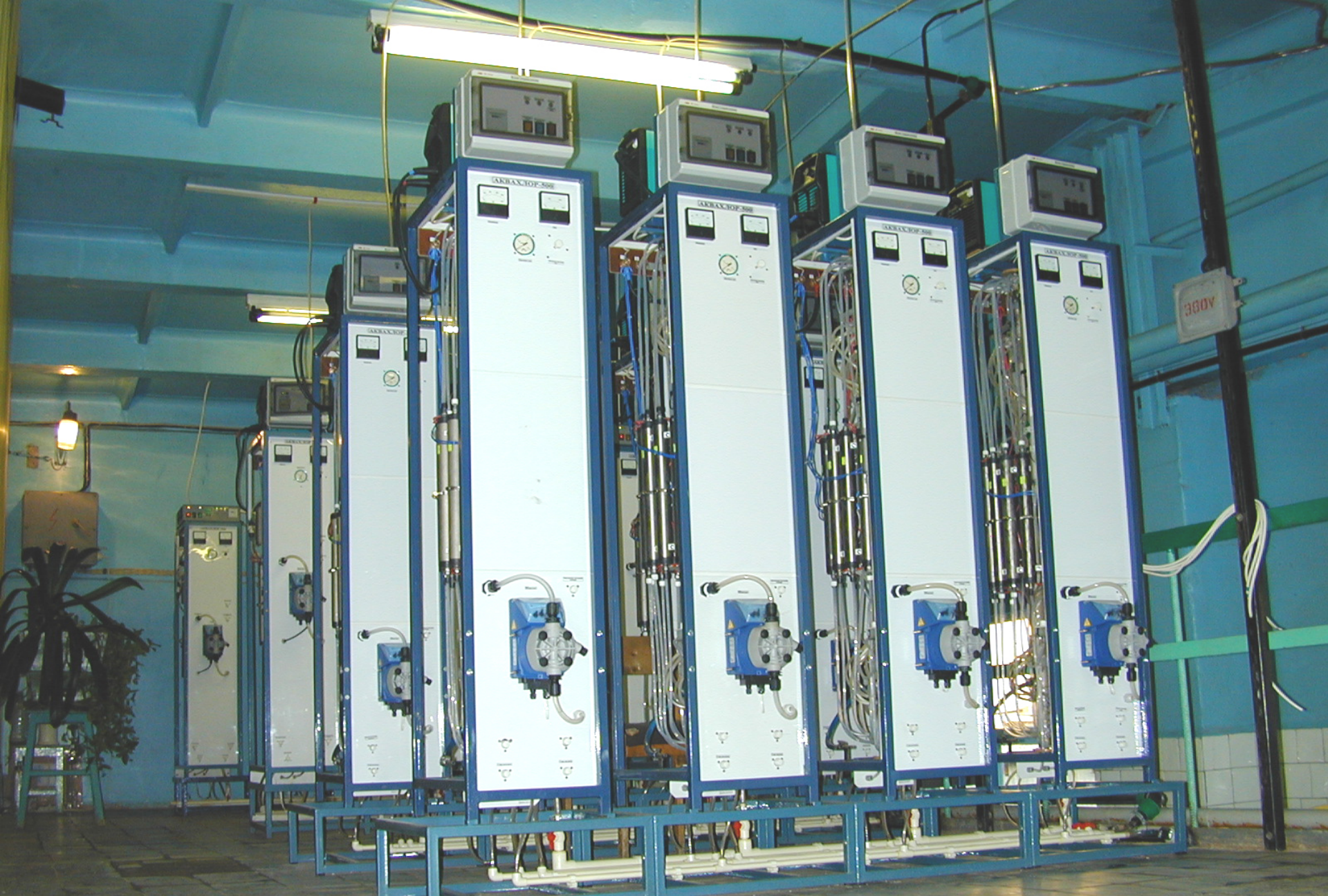
ВОС г. Энгельс, 2005. Шестнадцать установок АКВАХЛОР-500 обеспечивают обеззараживание питьевой воды из р. Волга. Раствор оксидантов напрямую подается в обрабатываемую воду, а катодит используется для промывки фильтров и в качестве растворителя коагулянта
