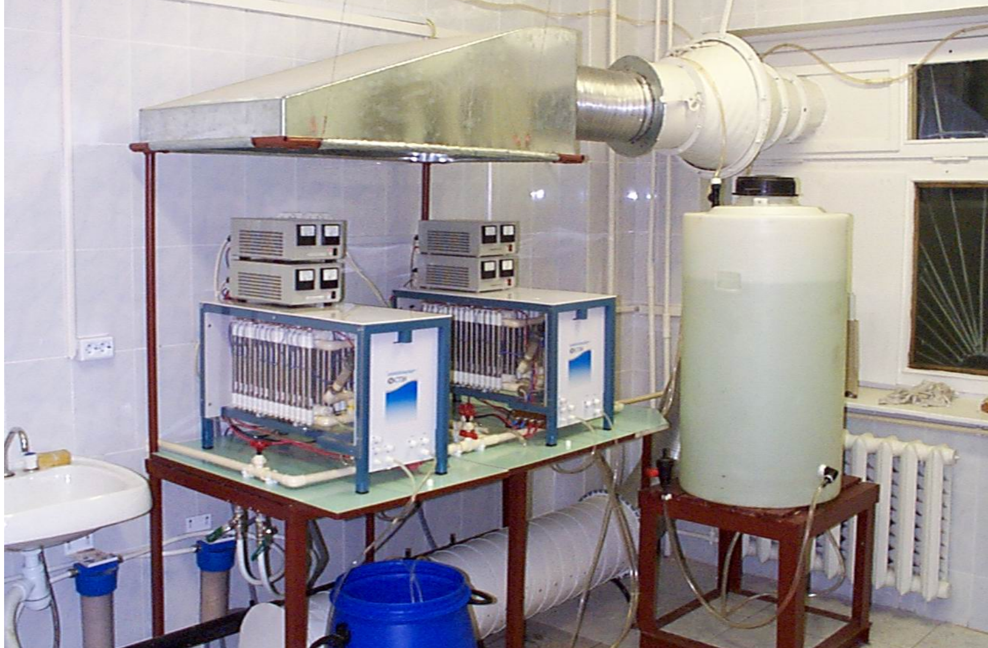
Установки СТЭЛ суммарной производительностью 1000 л/ч по анолиту АНК в ГКБ №15, г. Москва, 2000
