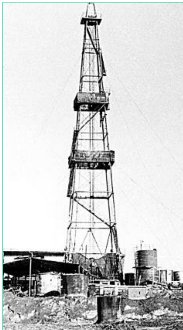
Буровая в пустыне Кызыл-Кум (месторождение Урта-Булак), где в 1973 году впервые был испытан метод регулирования параметров бурового раствора униполярным электрохимическим воздействием.
